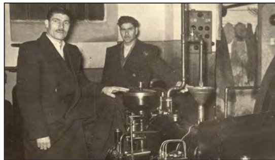
Εργοστάσιο παραγωγής ηλεκτρικής ενέργειας Κατάκαλου
